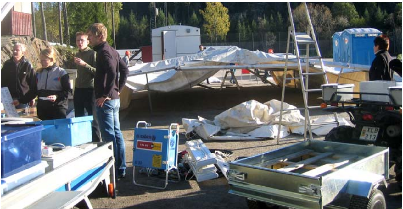
Rivningsarbetet gick som en dans och allt var klart vid femtiden.
