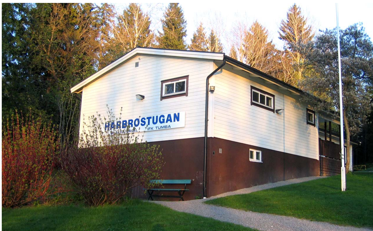
Harbrostugan – innan vattenskadan upptäcktes
